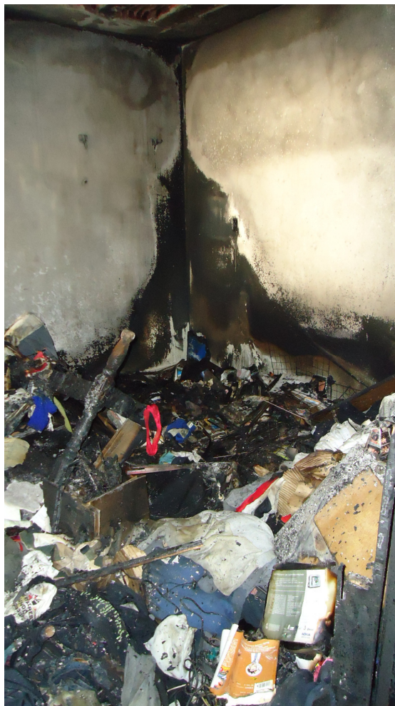
Figura 8: Foco em ampulheta.
