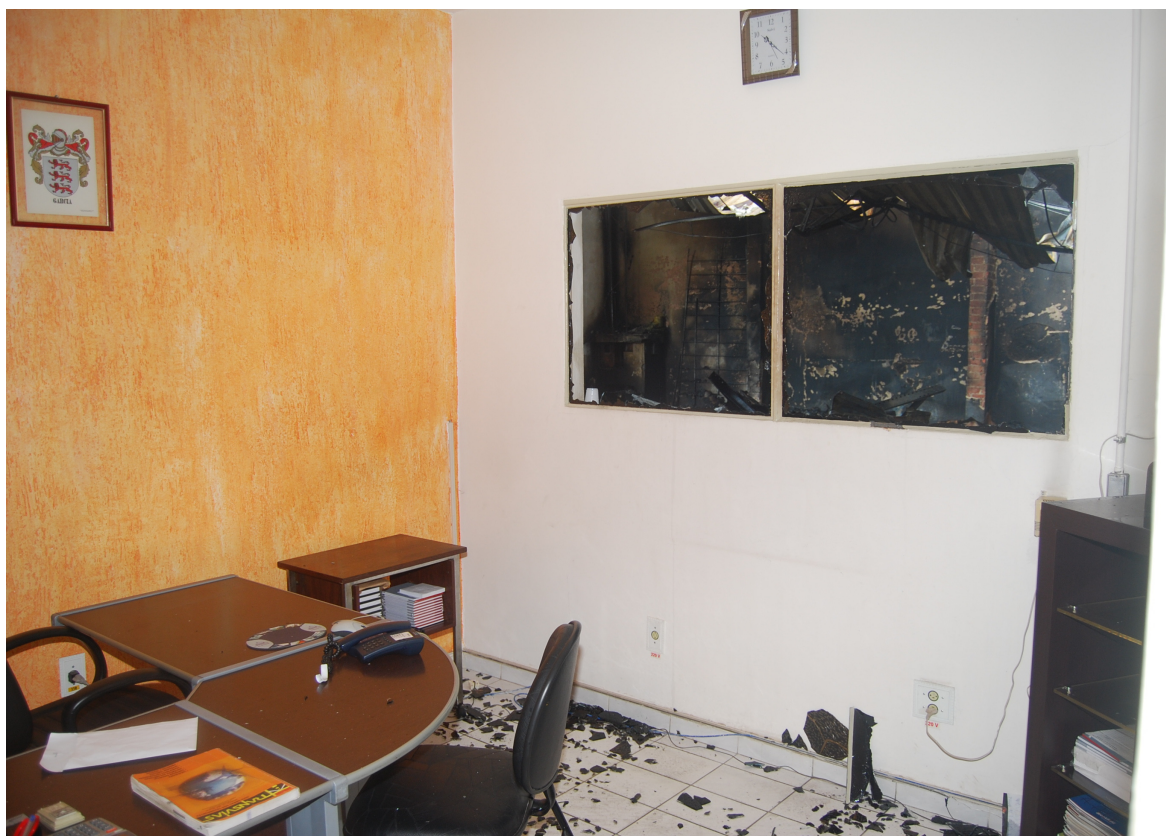
Figura 3: Vidro estilhaçado pelo calor das chamas, de fora para dentro, com emprego de fumaça. Fonte: Laudo Técnico Pericial de Monica Bernardi Urias – Guarulhos/SP – 17/02/2011.
