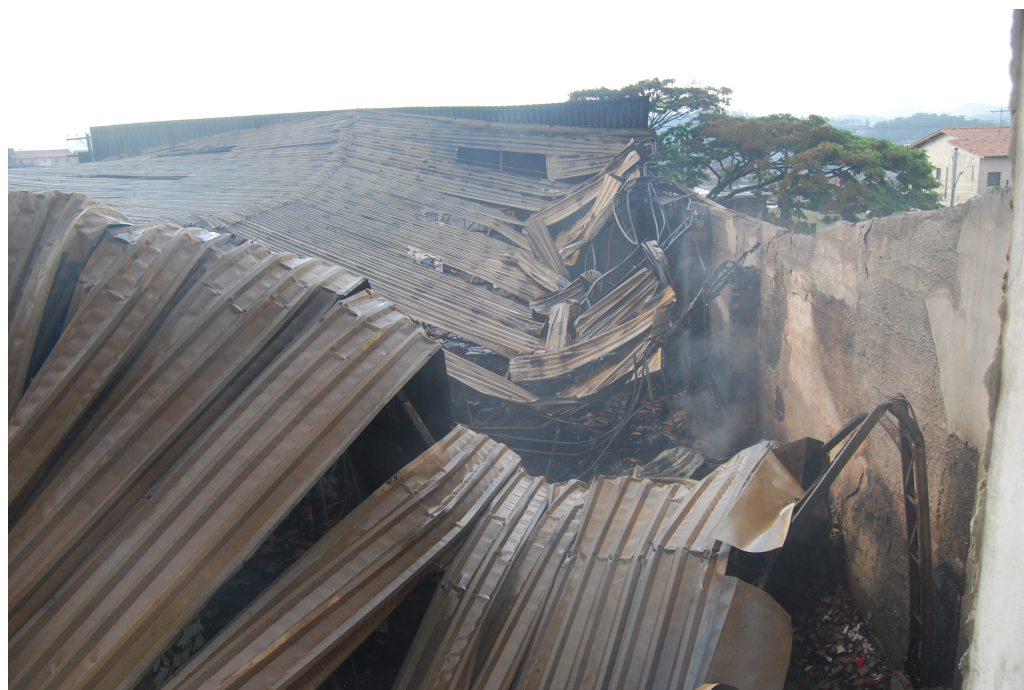
Figura 4: Estrutura metálica fletida com o calor das chamas. Fonte: Laudo Técnico Pericial de Monica Bernardi Urias – Guarulhos/SP – 17/05/2011.
