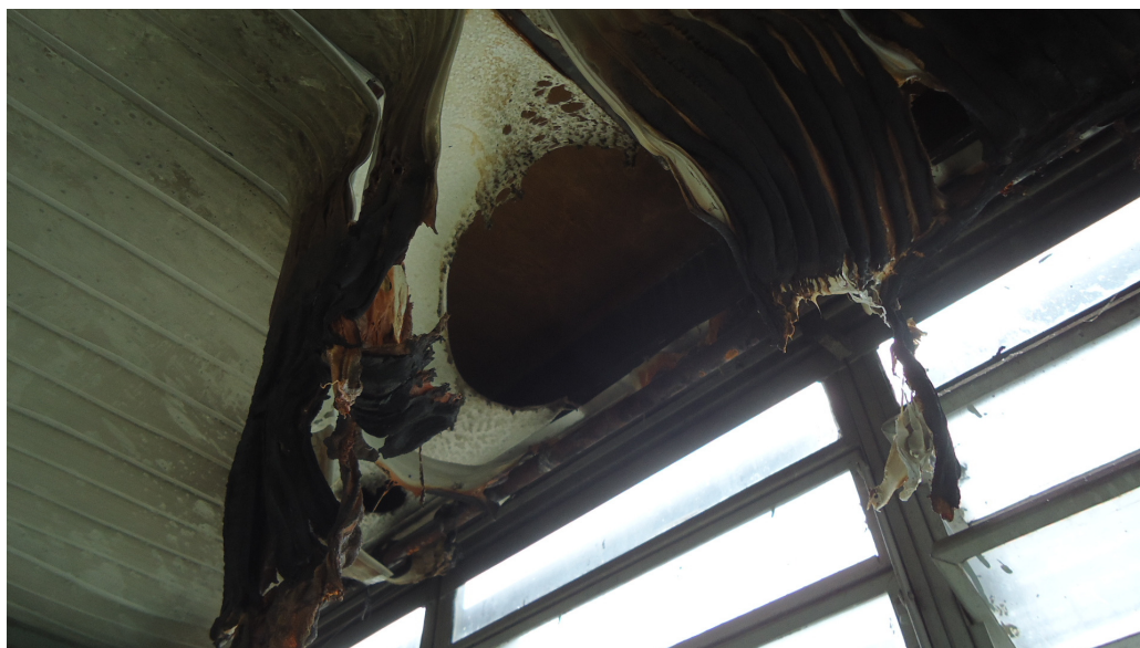
Figura 10: Foco secundário à parte superior do teto, tendo o fogo sido conduzido da parte, baixa para a alta através de cortinas, consumidas no incêndio – observar vestígios do pano Fonte: Laudo Técnico Pericial de Monica Bernardi Urias - Guarulhos/SP – 13/04/2011.
