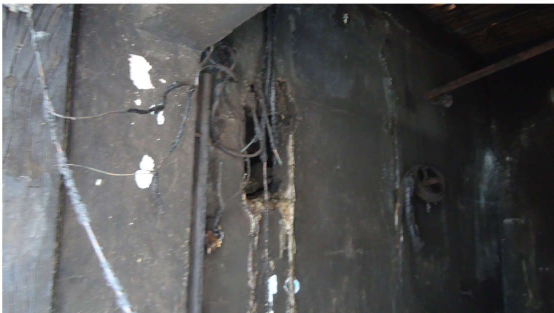
Figura 15: Distribuição de energia – quadro sem disjuntor – local do foco do fogo. Fonte: Laudo Técnico Pericial de Monica Bernardi Urias - Guarulhos/SP – 24/07/2011.
