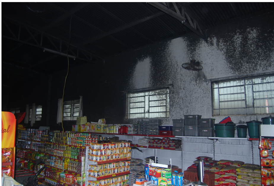
Figura 17: Local de incêndio - supermercado com ventilação forçada por exaustores. Fonte: Laudo Técnico Pericial de Monica Bernardi Urias – Pereira Barreto – 18/05/2010.
