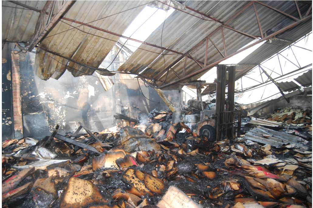
Figura 11: Incêndio decorrente de explosão – tanque combustível (gás) da empilhadeira.
