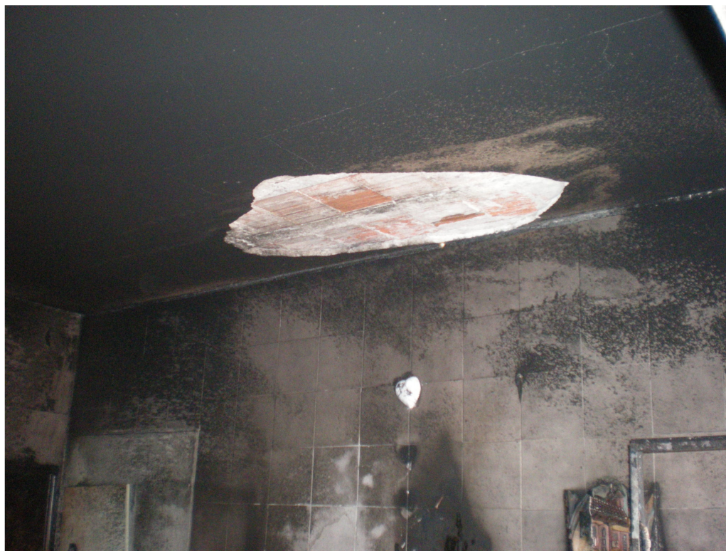
Figura 6: Ponto imediatamente acima do foco do fogo. Fonte: Laudo Técnico Pericial de Monica Bernardi Urias – Guarulhos/SP – 29/05/2011.
