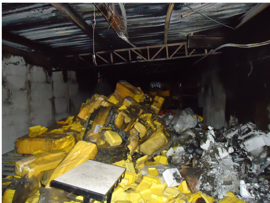
Figura 7: Carga de incêndio - embalagens de isopor, parcialmente consumidas à superfície. Fonte: Laudo Técnico Pericial de Monica Bernardi Urias – Franco da Rocha/SP – 13/06/2011.
