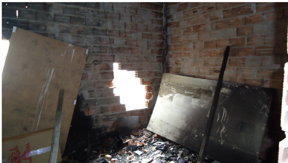
Figura 16: Incendiarismo – vão aberto na parede de fora para dentro para acesso ao cômodo. Fonte: Laudo Técnico Pericial de Monica Bernardi Urias - Guarulhos/SP – 30/05/2011.
