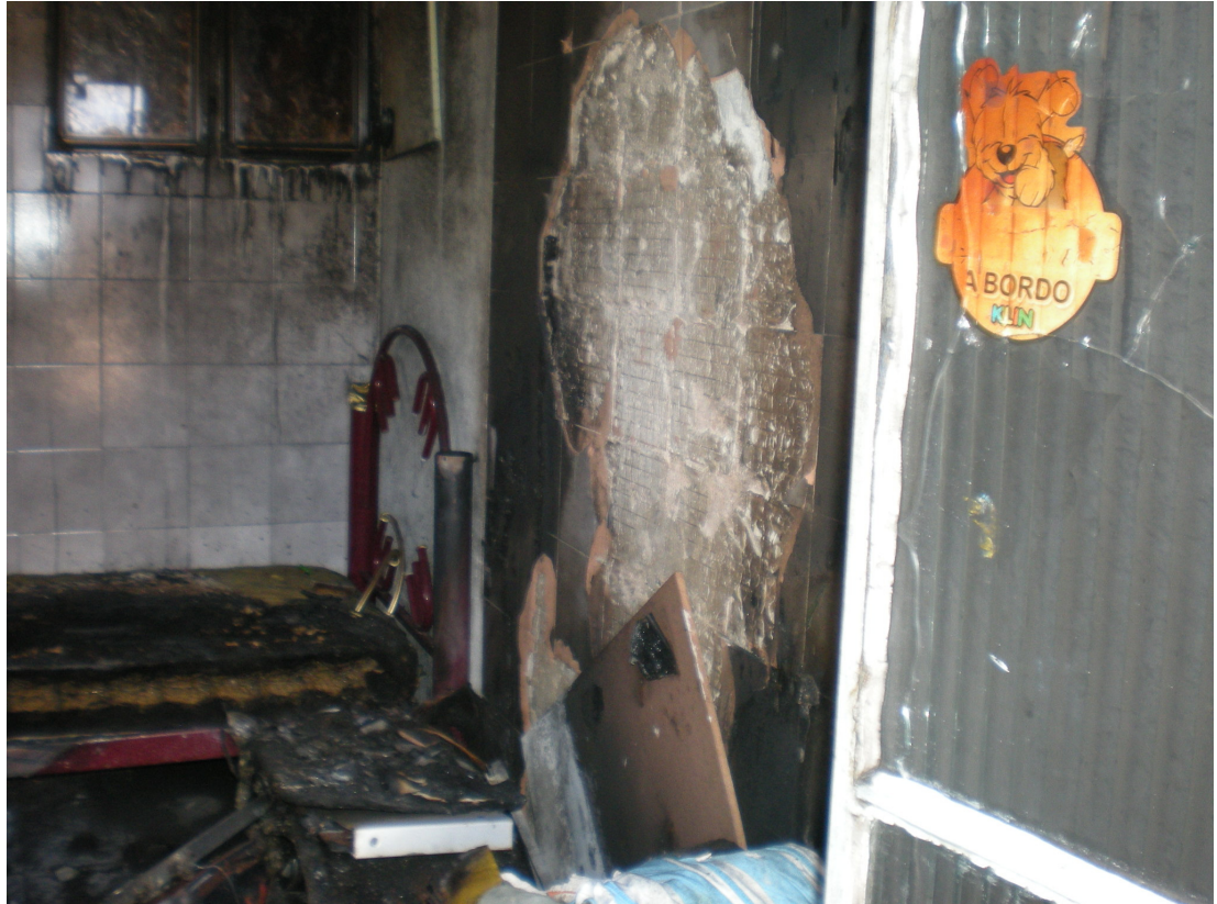
Figura 5: Foco de incêndio – colapso superficial – revestimento da parede. Fonte: Laudo Técnico Pericial de Monica Bernardi Urias – Guarulhos/SP – 29/05/2011.
